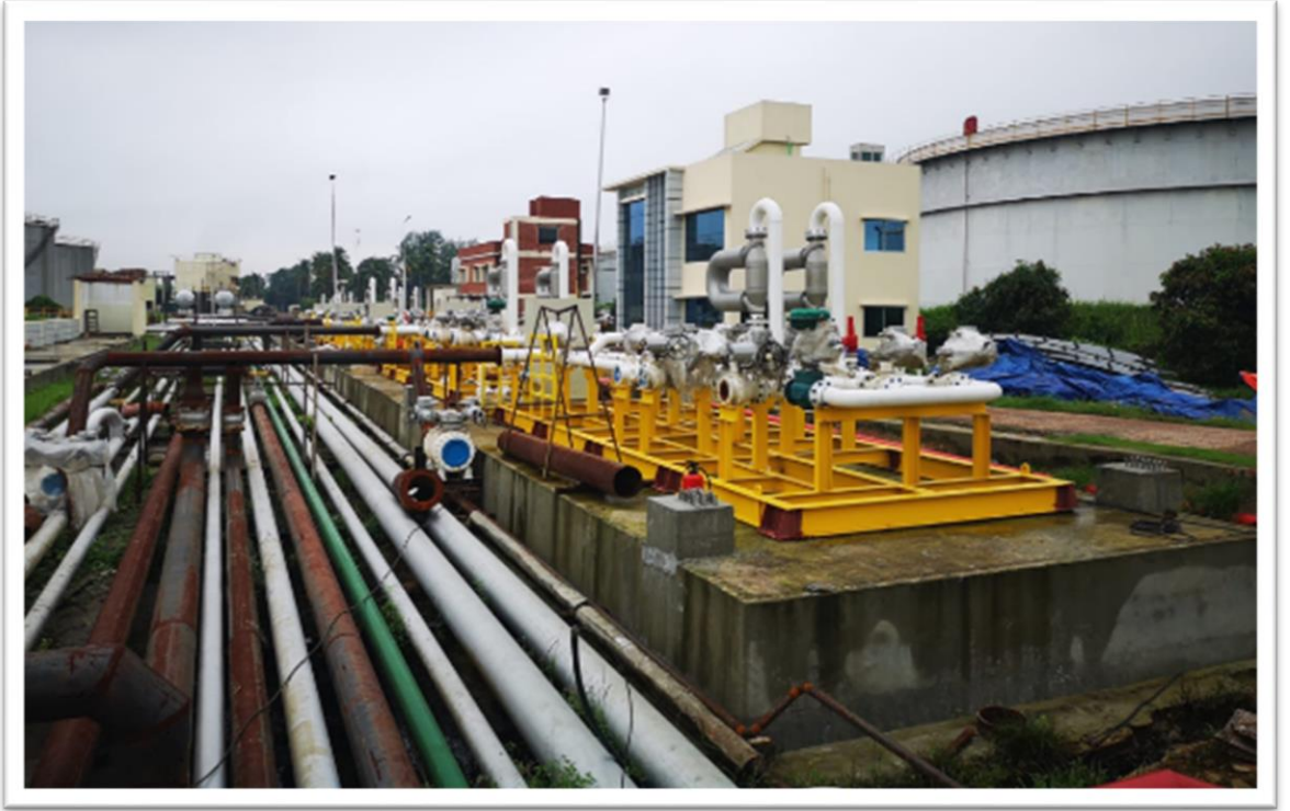
চিত্রঃ অটোমেশনের লক্ষ্যে স্থাপিত কাস্টডি ট্রান্সফার ফ্লো-মিটার
